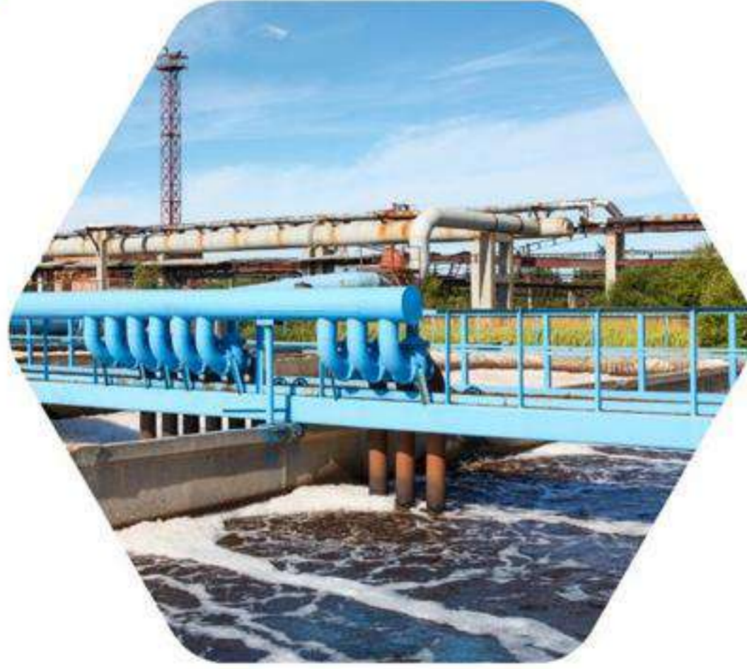
Atıksu Arıtma Tesisi
