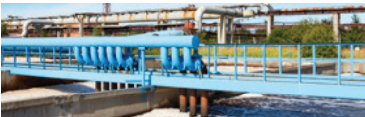
Atıksu Arıtma Tesisi
