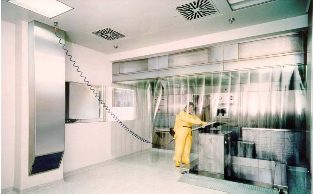
Resim 9: Örnek; Numune alma bölümünün laminar ve turbulent olarak iklimlendirilmesi
